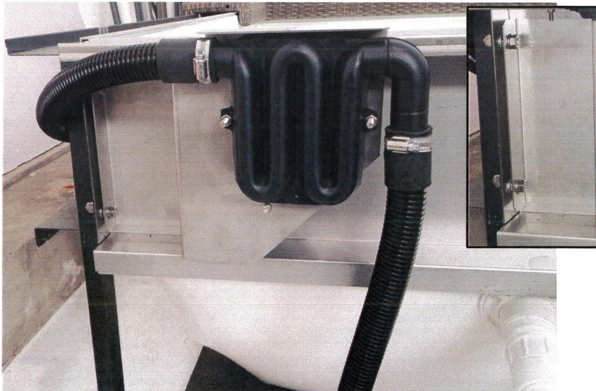
4. Collegare il gomito filettato al passante aria saldato al telo e montare i tubi per l'aria fissandoli con le apposite fascette a vite
