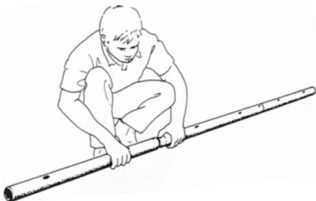
**3.** Assembler les tubes formant les barres supérieures, en commençant par un tube de type **A**, puis par les tubes de type **B** selon la quantité requise (cf. tableau ci-avant) et en finissant avec un tube de type **C**.
